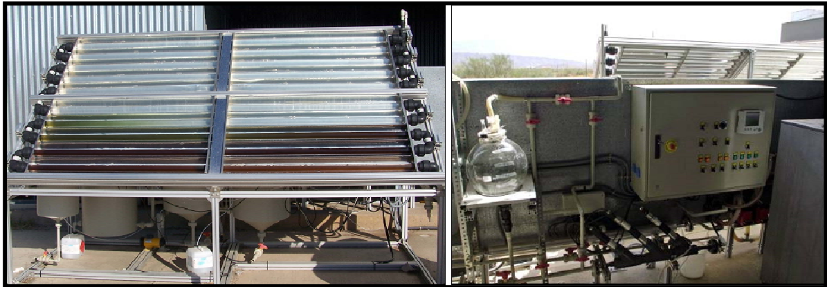
Figura 3.13. Fotografía de los cuatro módulos de captadores CPC durante un ensayo de foto-Fenton (izda.) e interior de la caseta que protege al tanque de recirculación, los sensores, el sistema de calefacción y refrigeración y el cuadro eléctrico (dcha.).
